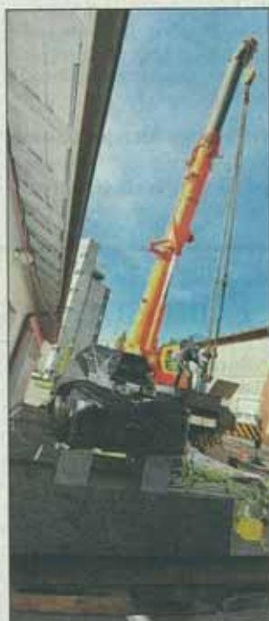
Ein Kran lud den schweren Tisch auf dem Empa-Areal ab.
